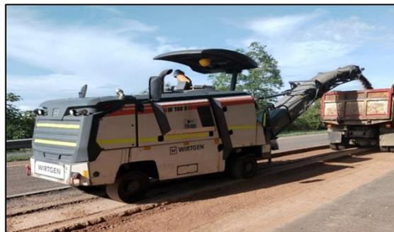
Ilustración 7 Proceso de fresado
