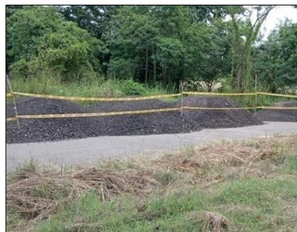
Ilustración 8 Acopio de fresado
