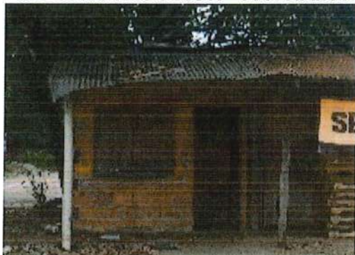
C3 CONSTRUCCION - FACHADA
