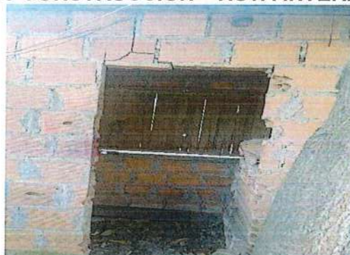
C3 CONSTRUCCION - VISTA INTERNA
