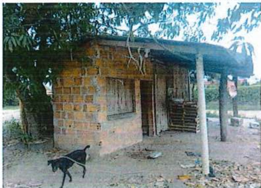
C3 CONSTRUCCION - VISTA LATERAL
