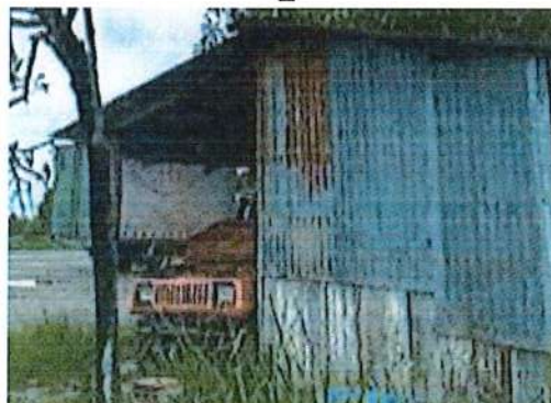
C2 CONSTRUCCION - VISTA LATERAL 2
