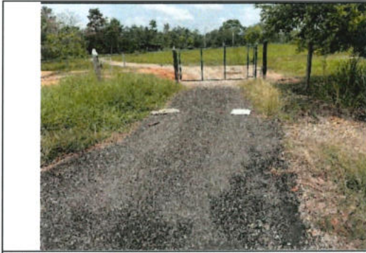
Vista CA-5 Acceso en material mixto de fresado
