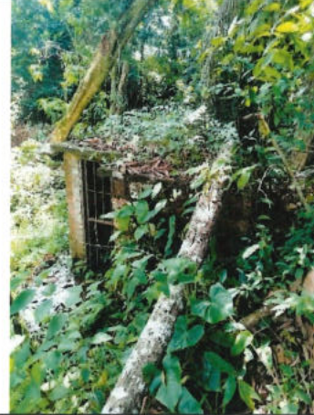
Vista CA-8 Pozo
