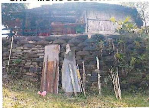
CA3 – MURO DE CONTENCIÓN
